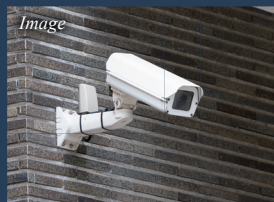
共用部に防犯カメラ設置
