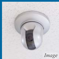
共用部に 防犯カメラ設置
