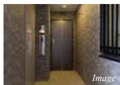
内廊下仕様の共用部
