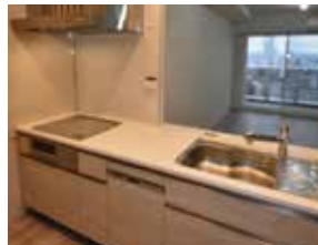
ビルドイン浄水器・食洗器
