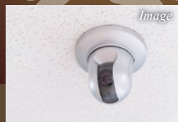
共用部防犯カメラ3台設置
