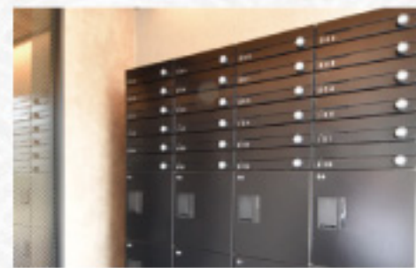
宅配ボックス
