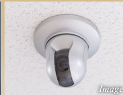
共用部防犯カメラ設置
