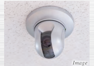
共用部防犯カメラ(9台設置)
